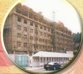
1994 校舍建築工程
